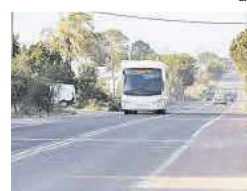
Tramo de la carretera principal.
