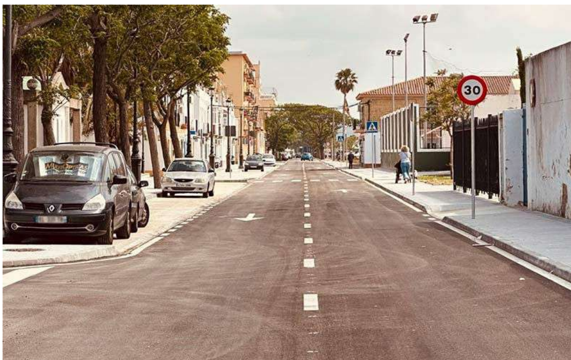
Tramo de avenida recién reasfaltada / FOTO: Ayto.
